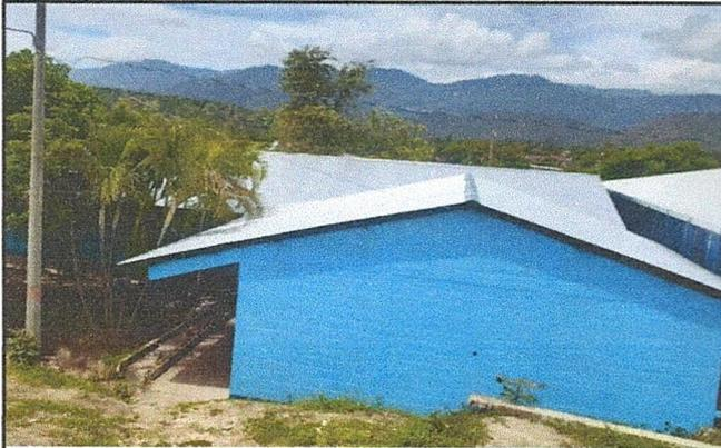
Foto 1: Mejoramiento de techo de lamina troquelada No. 26 y mantenimiento de estructura constante metalica.
